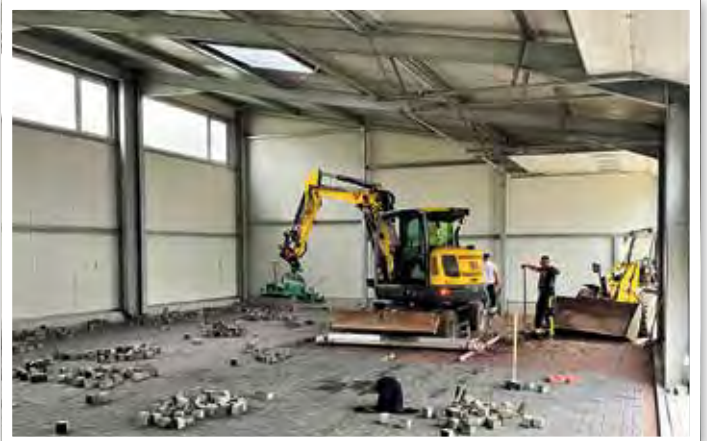
Pflasterarbeiten in der Fahrzeughalle
