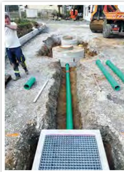
Verrohrung des Waschplatzes
