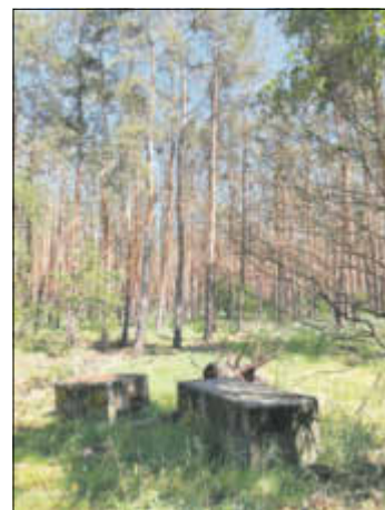
Restliche Fundamentsteine von Schmückers Mühle in Wald in Bergzow
