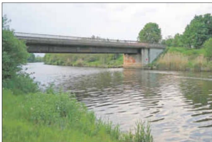
Brücke über den Verbindungskanal in Neuderben
