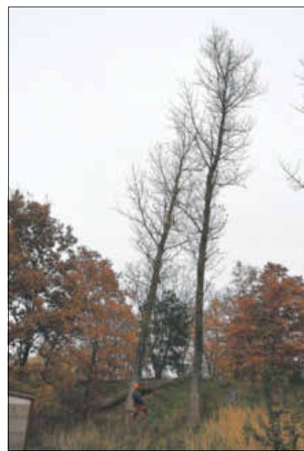
Baumfällarbeiten auf dem Sommerdeich
