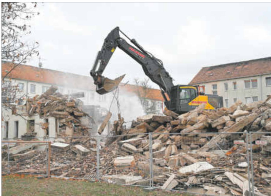
Der Abriss ist erfolgt, nun folgen die Aufräumarbeiten
