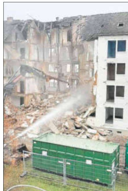
Abrissarbeiten Wohnblock „Lustgarten“
