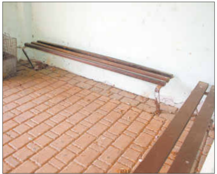
In 2021 wurden die Sitzflächen an der Bushaltestelle erneuert
